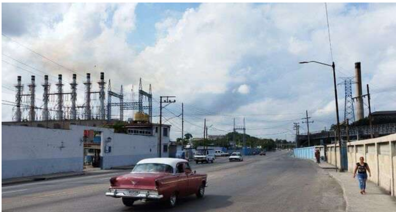
Visibles a la izquierda, las torres de la central flotante turca, conectada por cables de alta tensión con la planta de Tallapiedra, en La Habana. (14ymedio)
